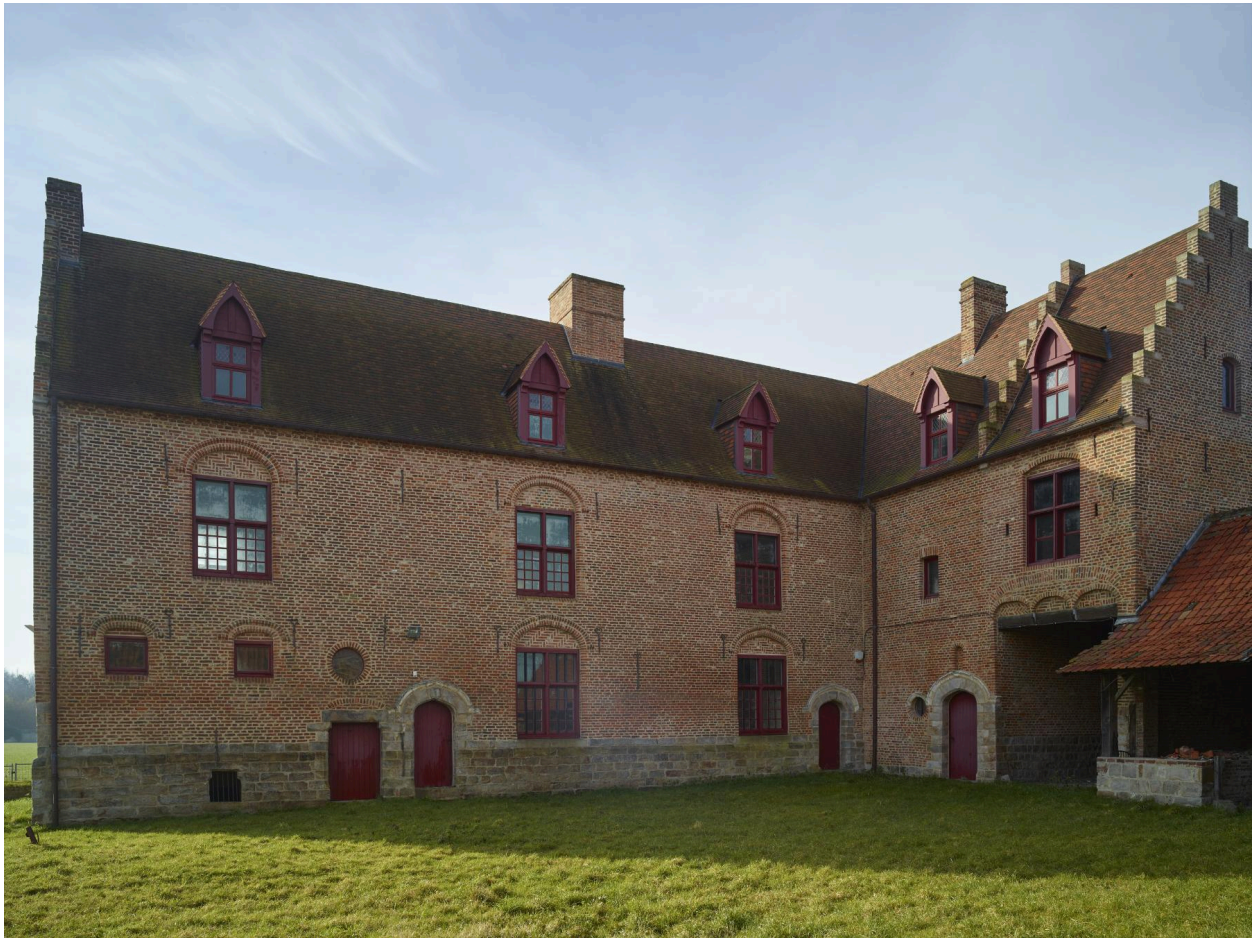
Vue des logis prise depuis l'intérieur de la cour.
