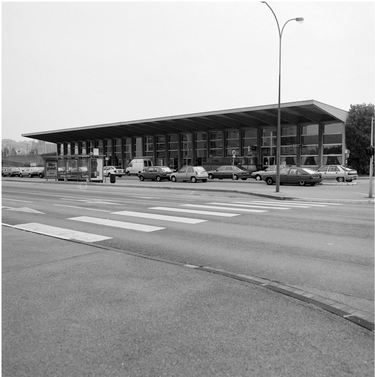
Vue d'angle nord-ouest.
