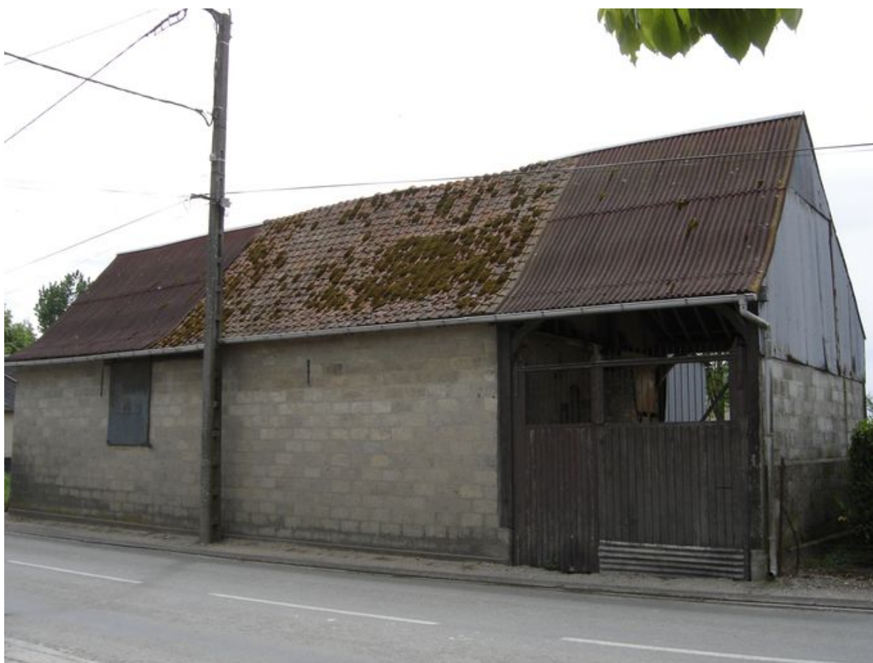
Vue générale de la grange.
