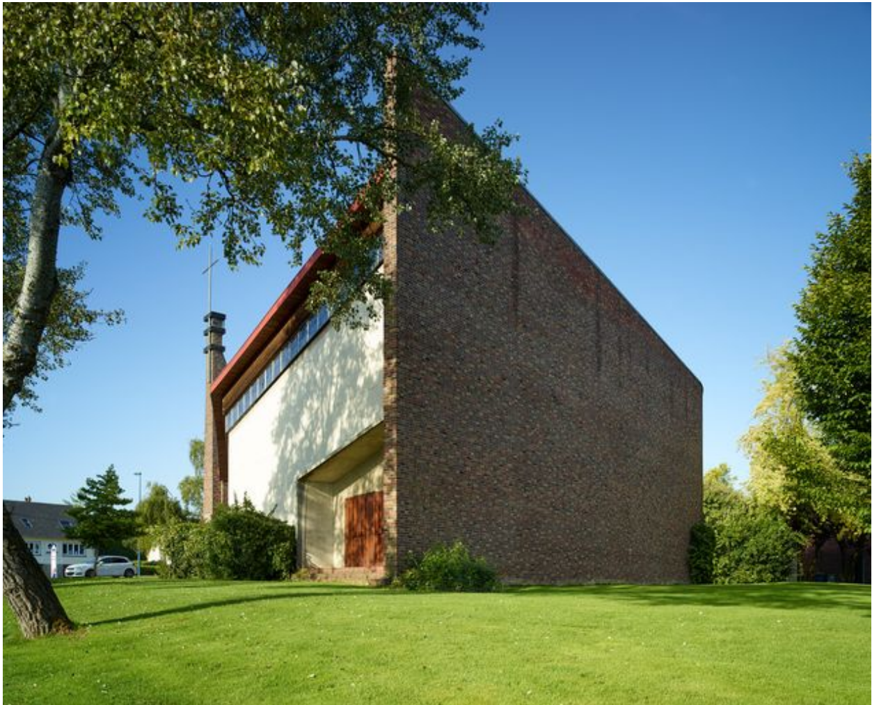
Élévation générale est et nord de l'église.
