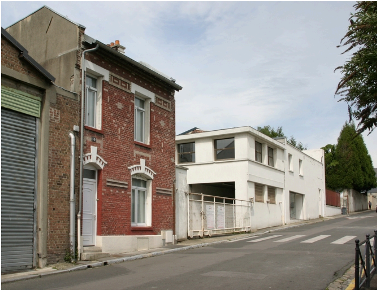
Entrée des bureaux et ateliers de 1959, rue des Patriotes. A gauche, autre accès aux ateliers.
