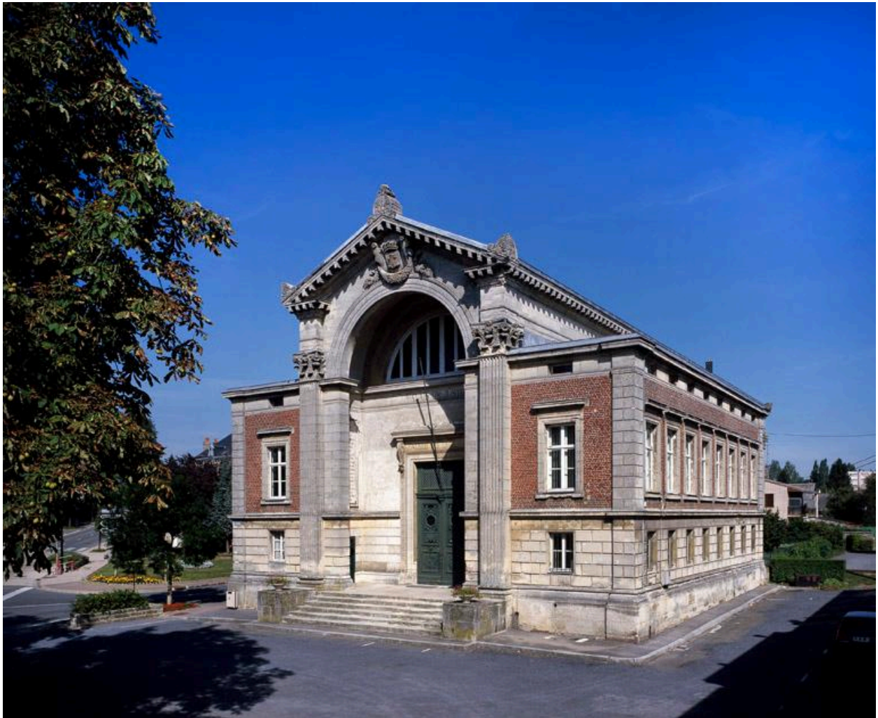
Vue des élévations sud et est du palais : état de la façade avant restauration en 1997.
