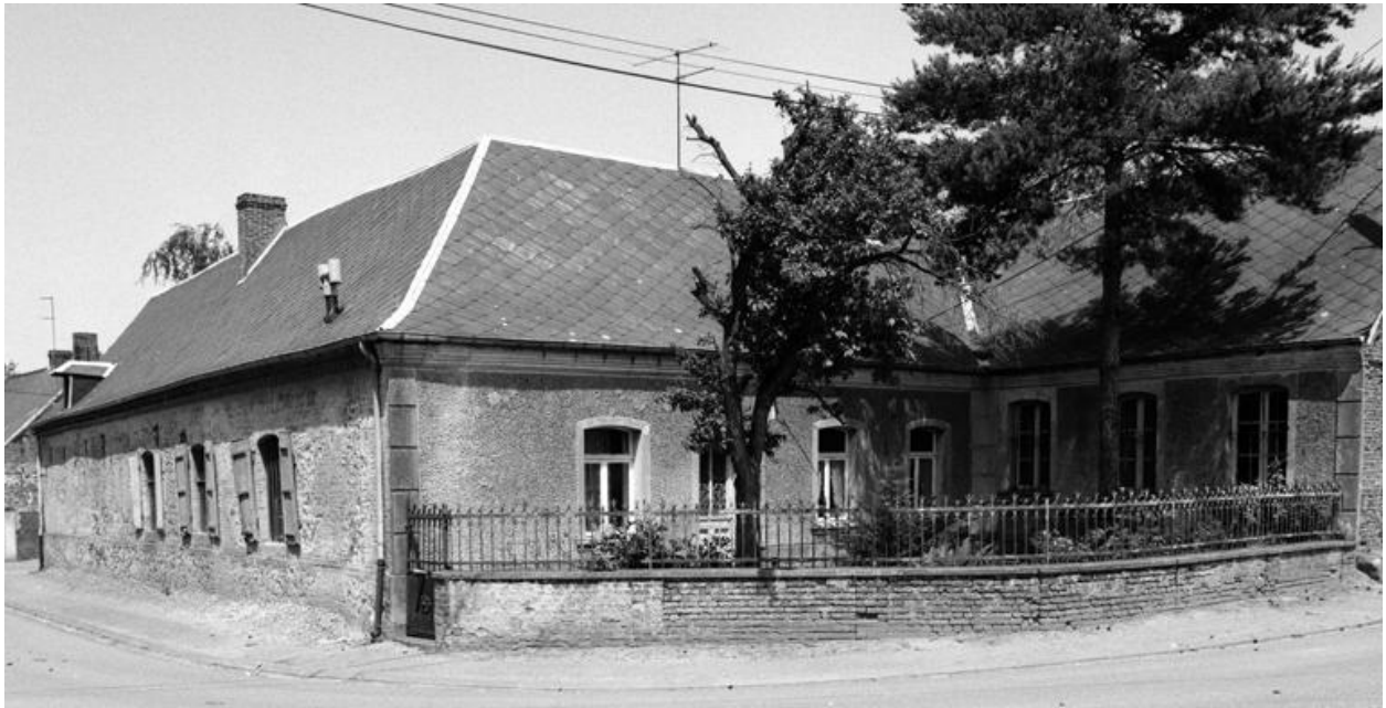
Vue d'ensemble du logis, depuis le sud.
