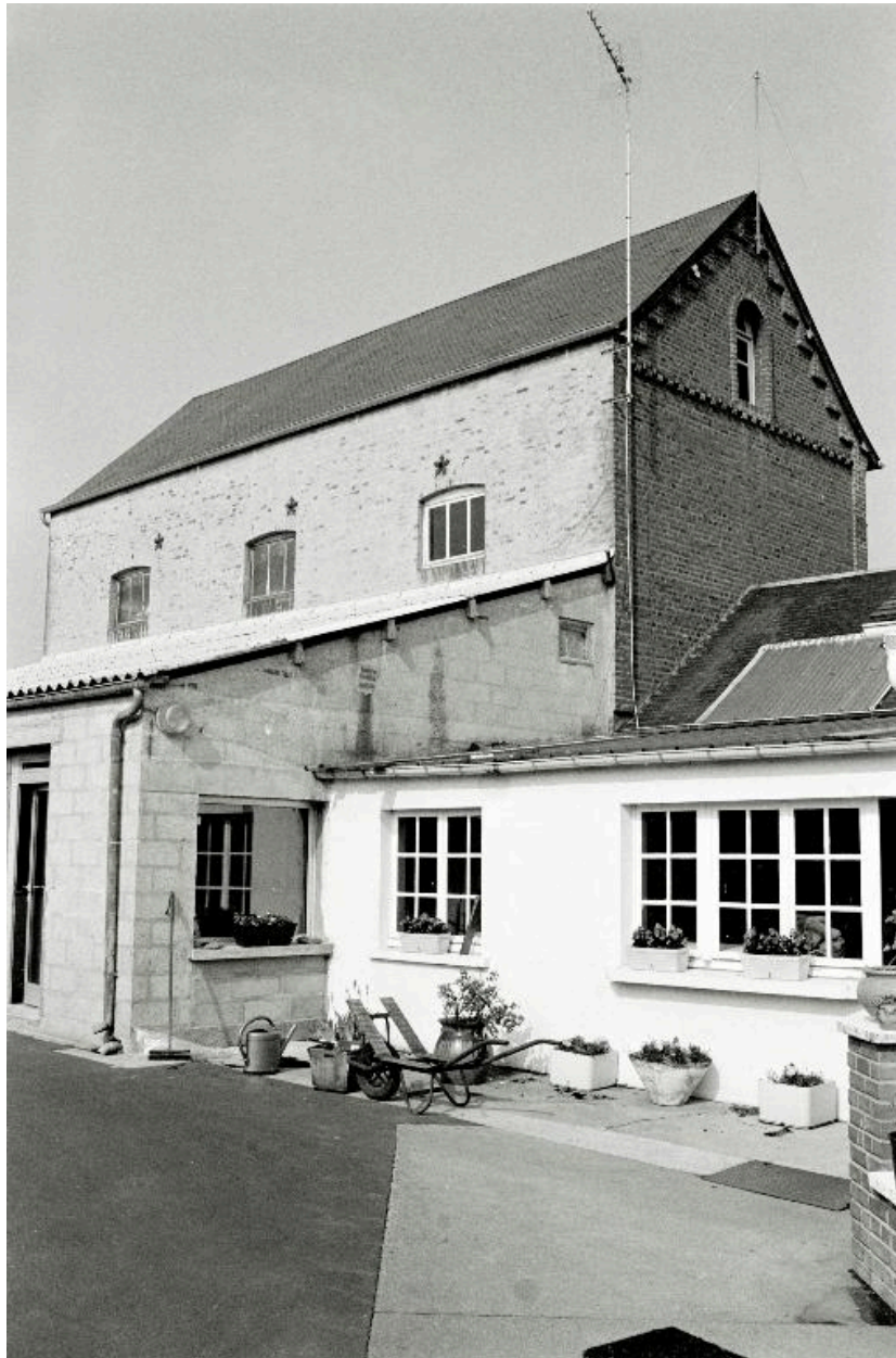
Vue des anciennes parties des ateliers.
