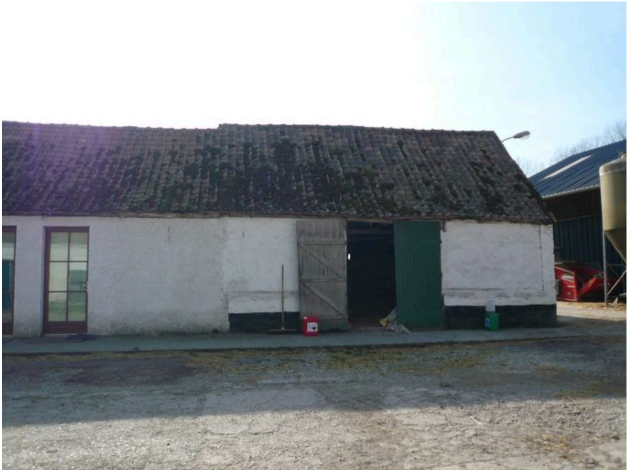
Vue des étables et de la charretterie dans le prolongement du logis.
