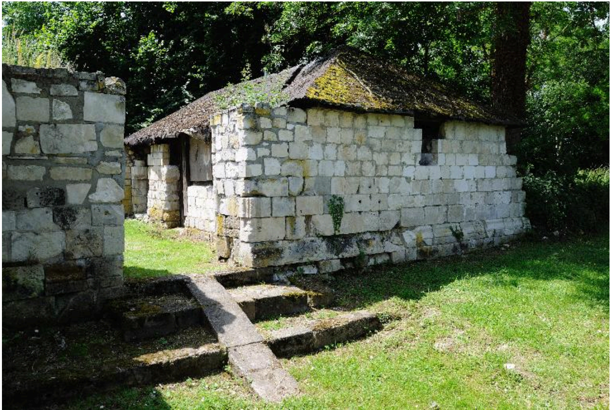
Ancien bâtiment bordant le cloître au sud.
