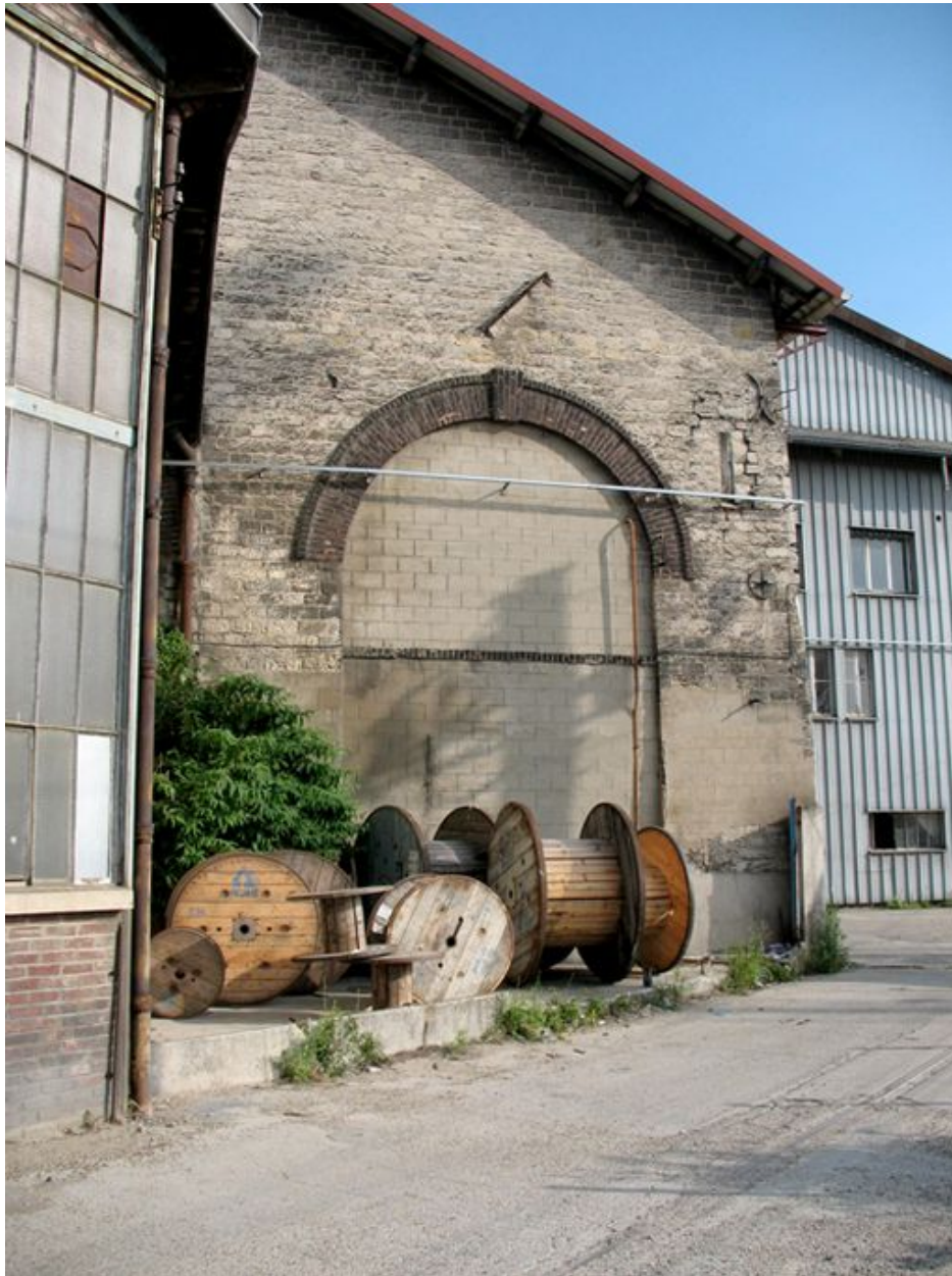
Vue partielle de l'atelier des ponts et charpentes.
