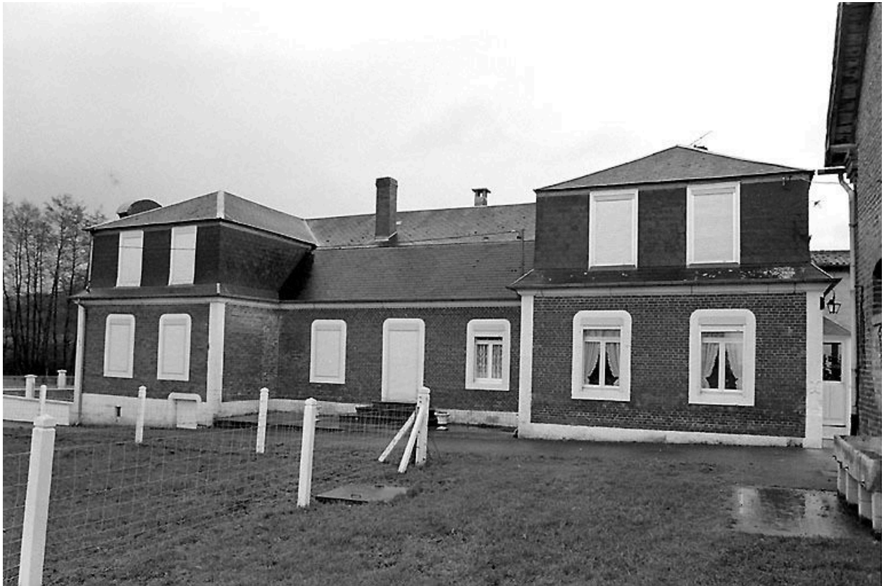
Elévation nord du logis.
