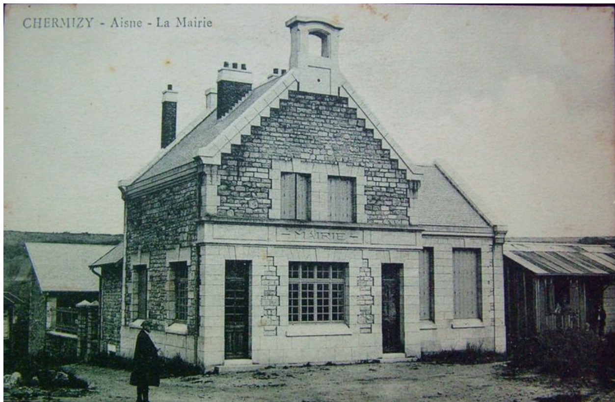
Vue de la mairie juste après sa reconstruction (coll. part).
