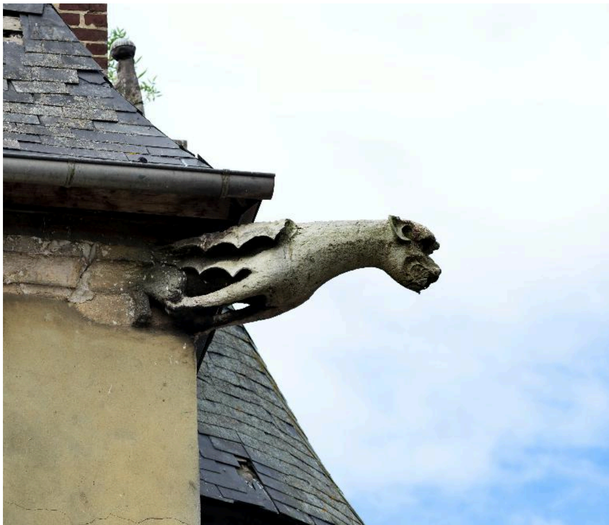
Détail d'une gargouille à droite de la corniche.
