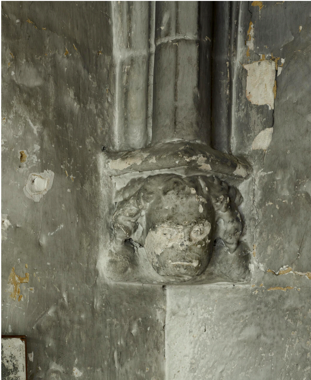
Intérieur de la salle du Conseil d'échevinage au premier étage du beffroi. Détail d'un cul de lampe sculpté à la base d'une retombée de voûte.
