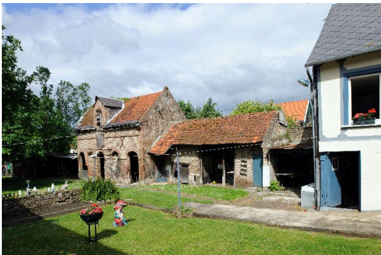
Etable et pigeonier, façade sur cour.
