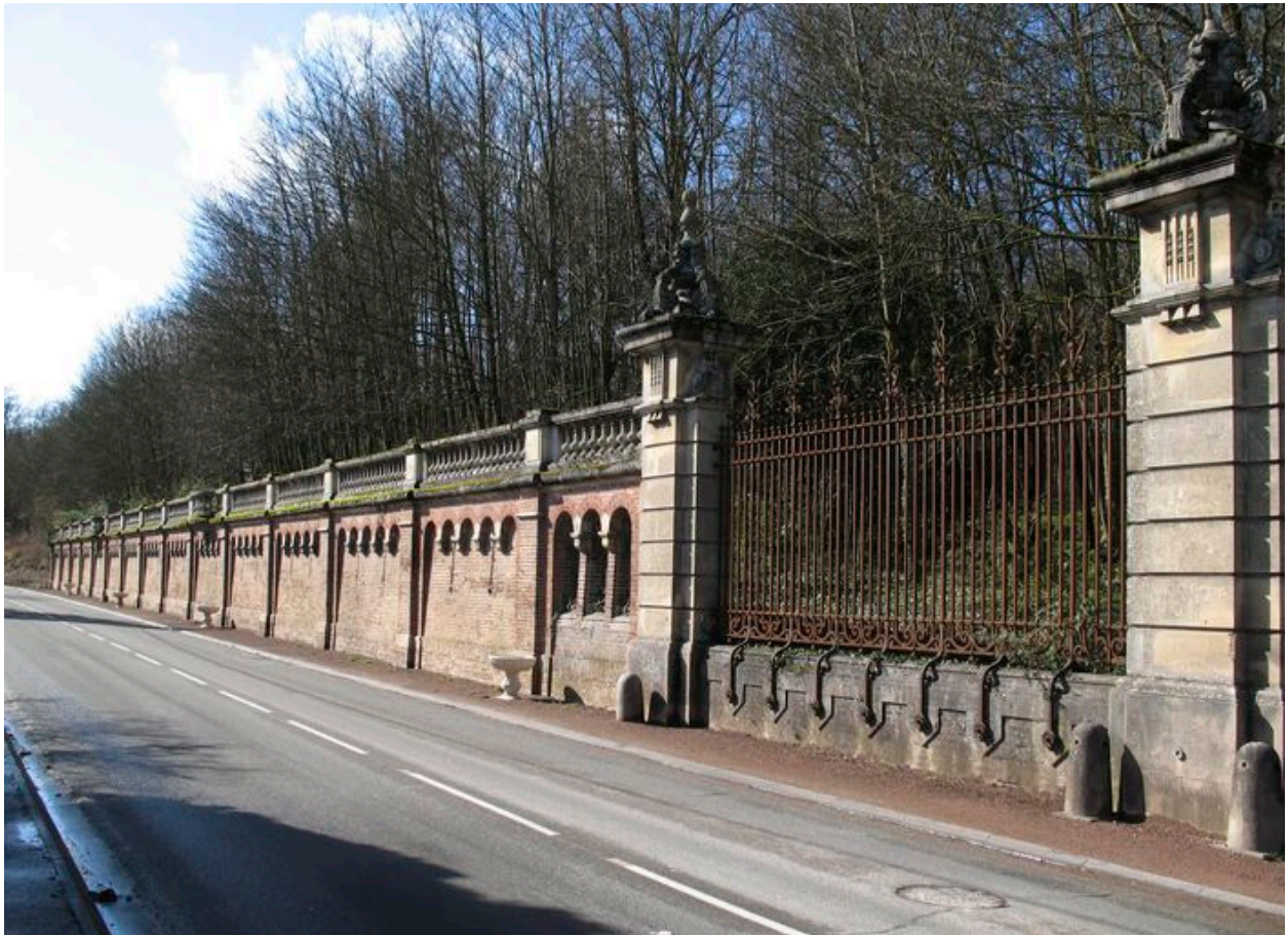
Mur de clôture.
