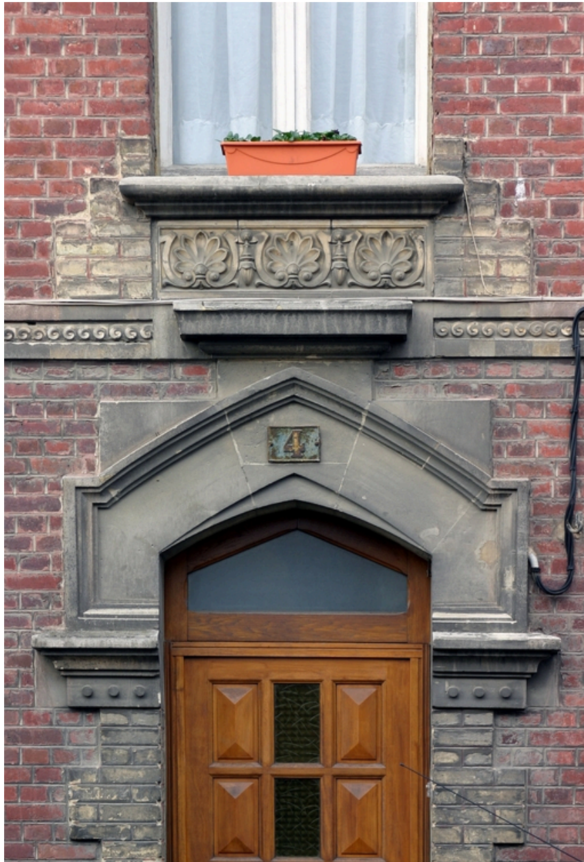
Façade, 4 rue du Général Foy : détail.
