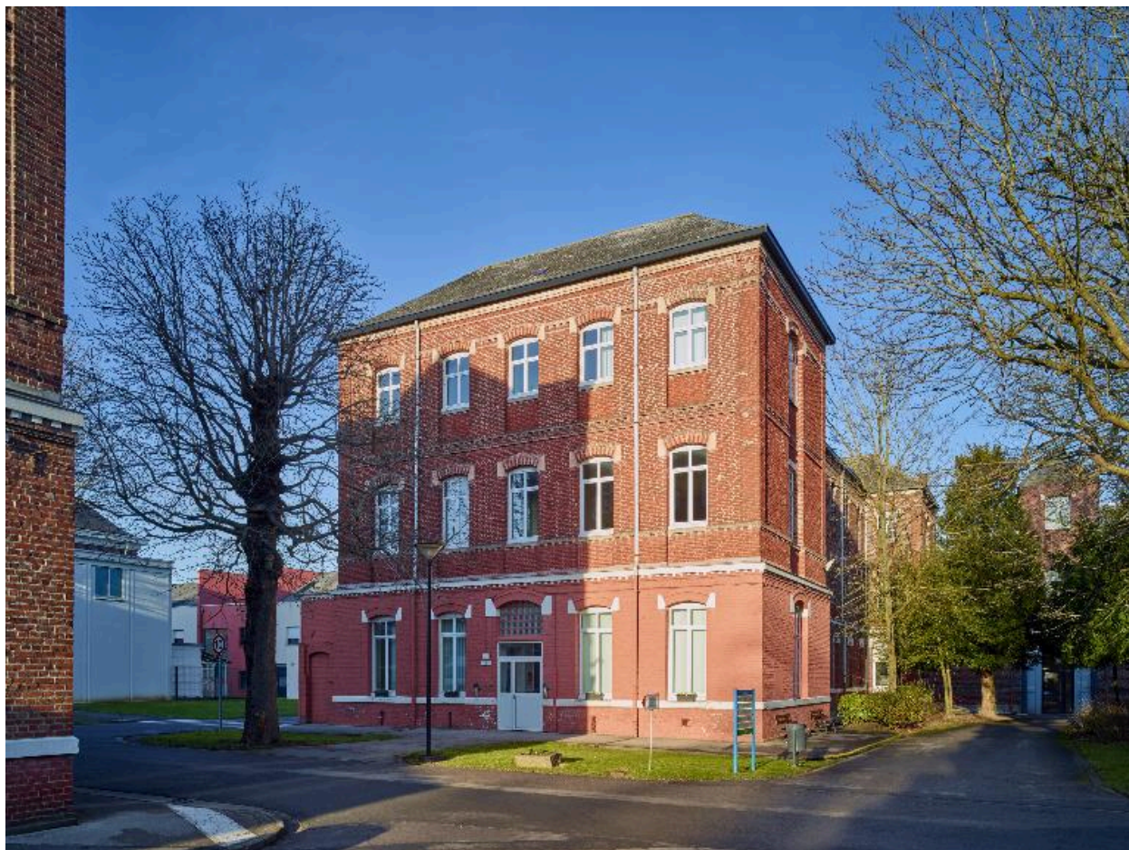
Bâtiment d'hospitalisation dit pavillon 2, élévation latérale gauche donnant sur l'espace médian formant l'axe de l'établissement, vue de trois quarts droit.
