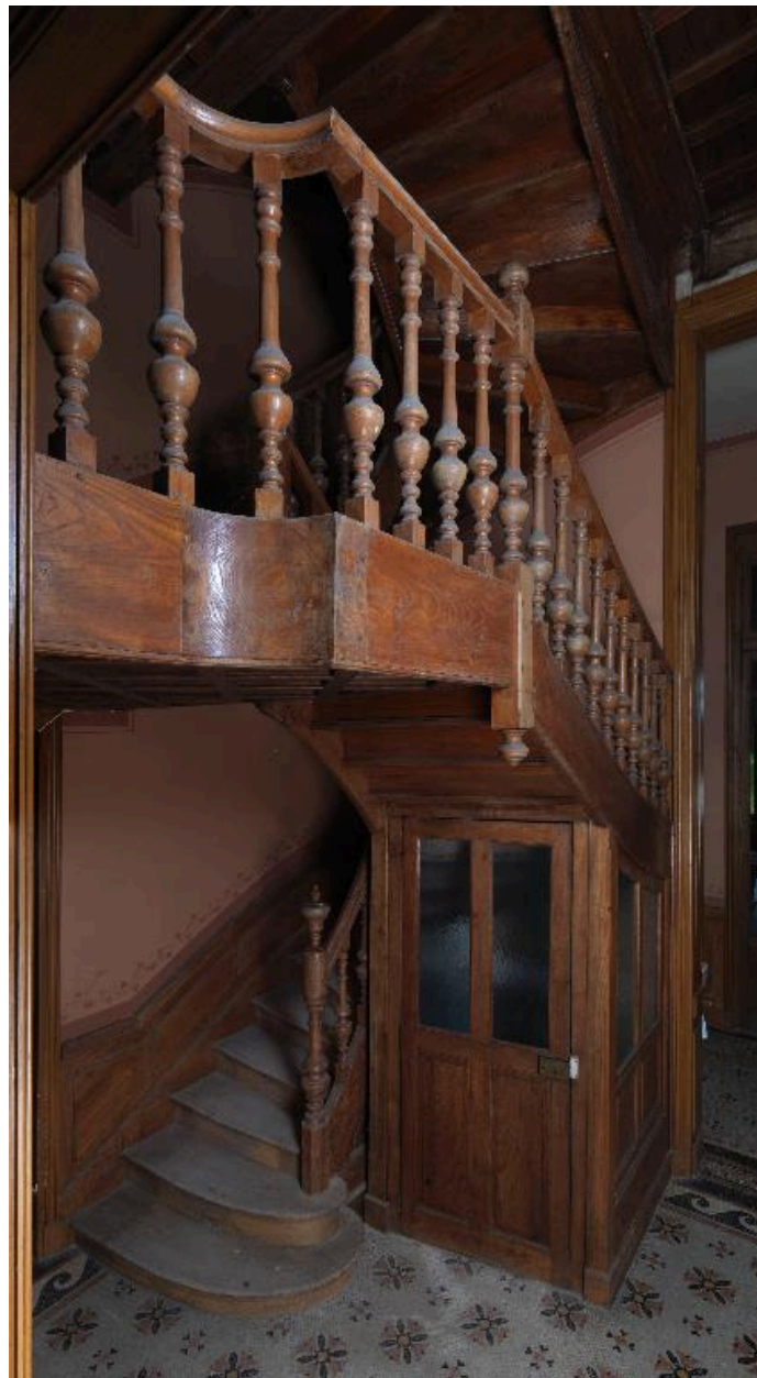
Escalier de service au rez-de-chaussée.
