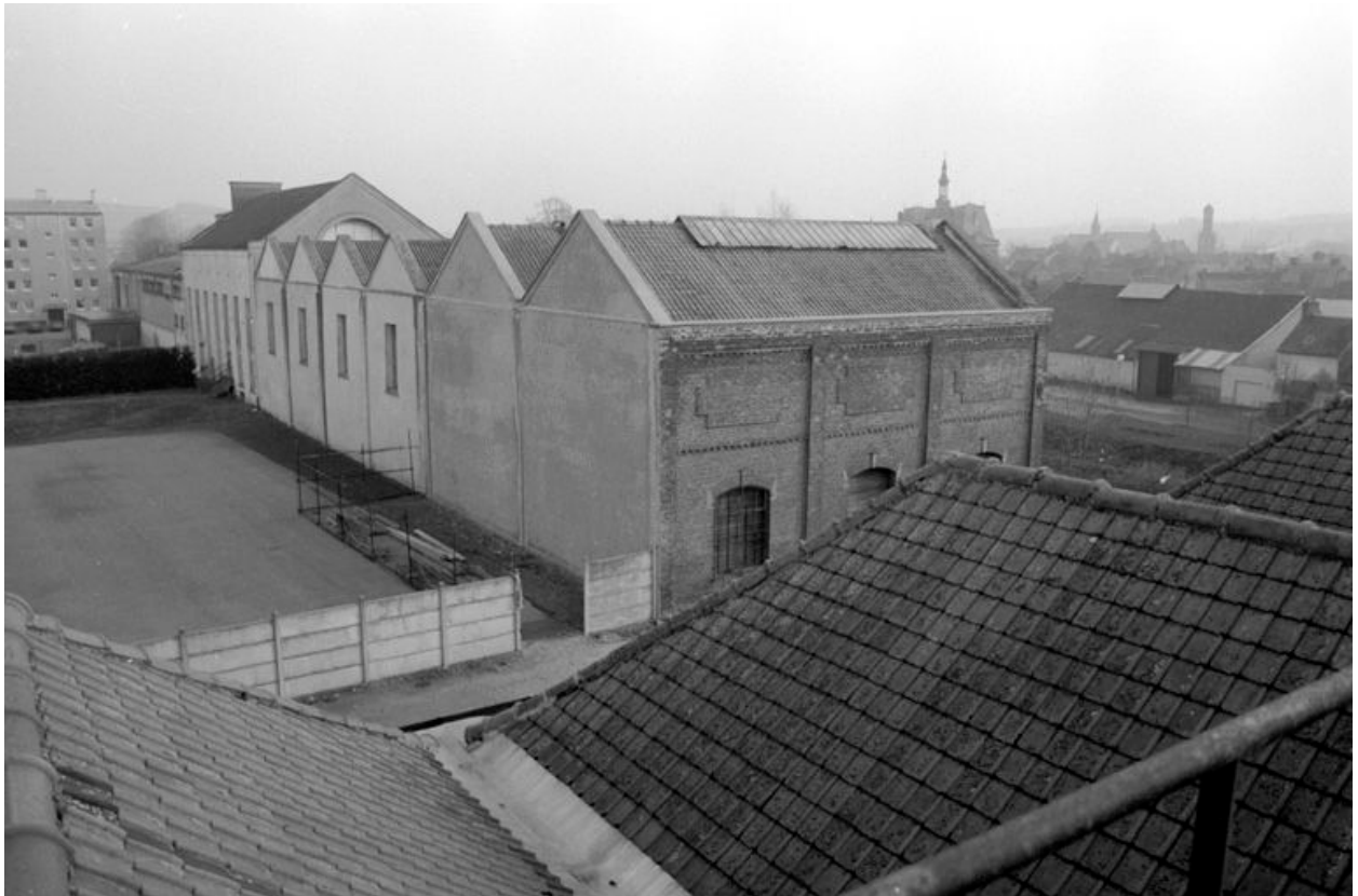
Vue générale des ateliers de fabrication et de la chaufferie, flanc nord.
