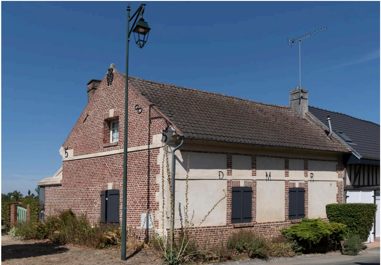
Maison avec date portée de 1855, n°6 rue du Château, vue depuis le sud.
