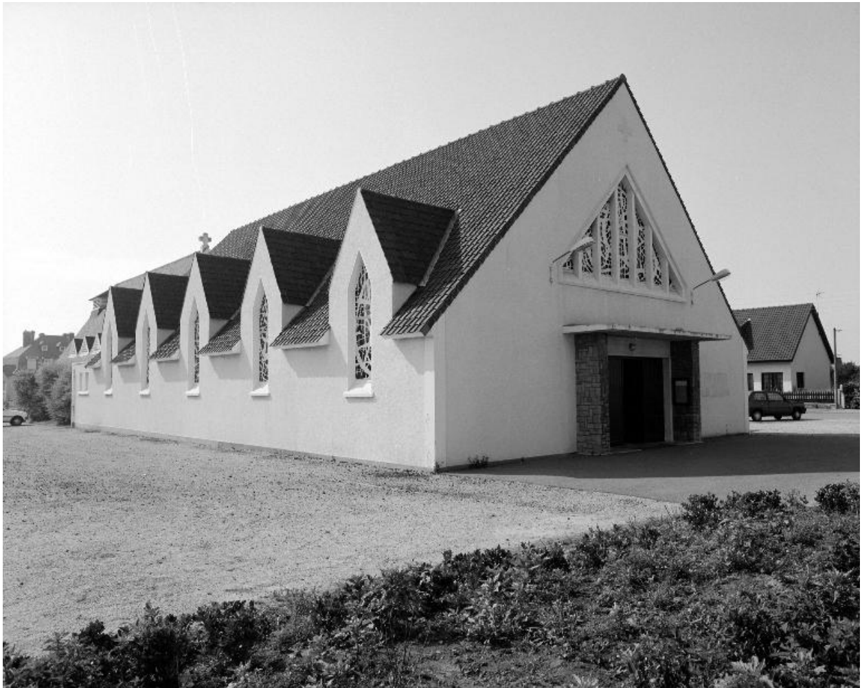
Vue d'angle sud-est.
