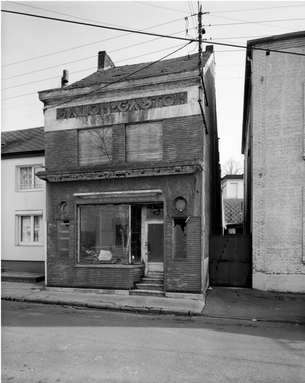
Vue générale de l'élévation antérieure.
