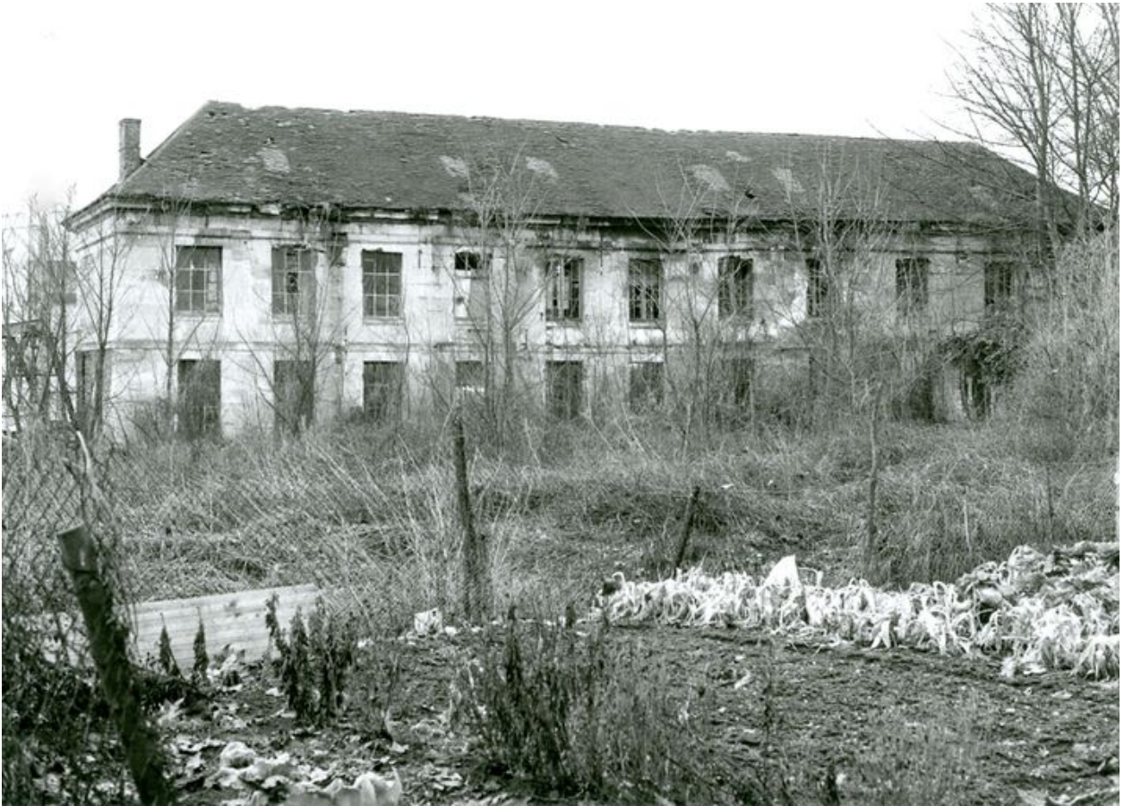
Usine III : Vestiges de bâtiments dépendants du moulin du château vers 1970 (AC Villers-Saint-Paul).
