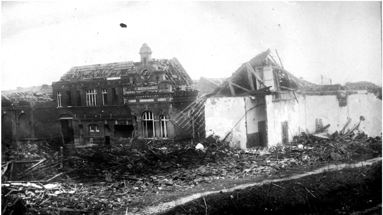
L'usine vue depuis l'angle de la rue Camille-Desmoulins et de la rue Sommières après la Première Guerre mondiale : au centre, le pignon des bureaux (AD Aisne).
