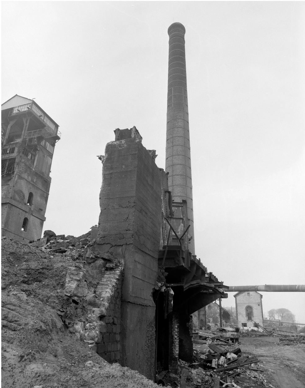
Vue d'ensemble (élévateur, cheminée d'usine, outillage).
