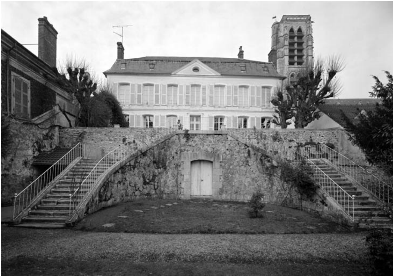
Vue générale prise du jardin.
