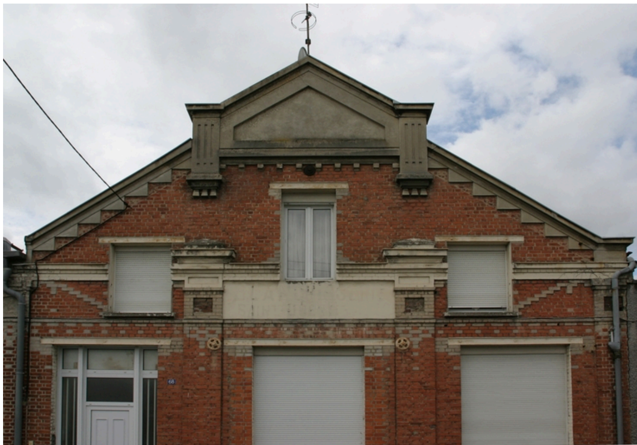
Détail de la façade antérieure des ateliers.
