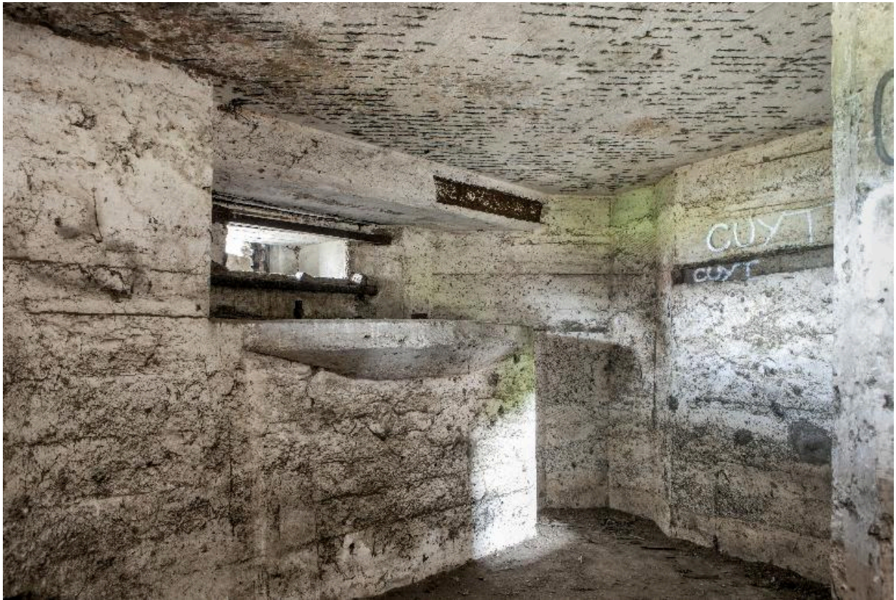
Rez-de-chaussée, appui pour mitrailleuse et embrasure de tir ouest (au grand-angulaire)
