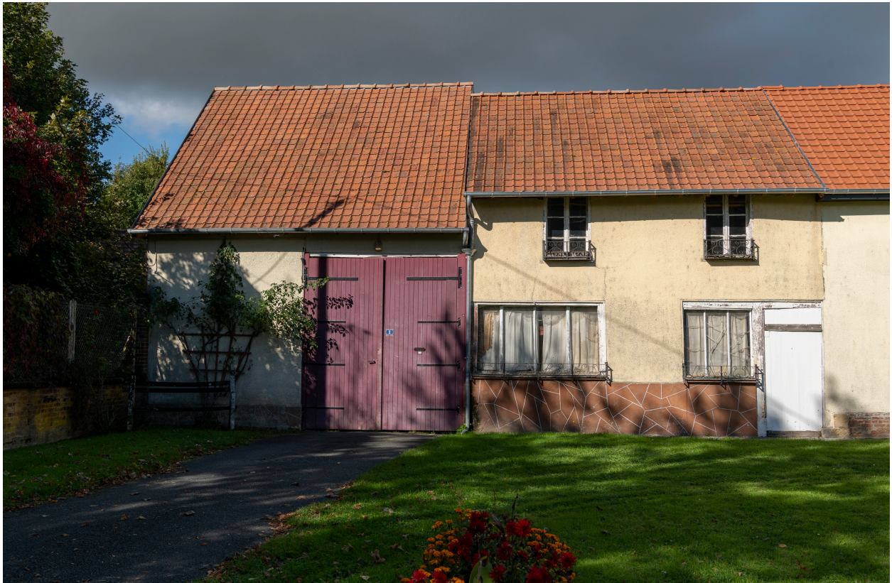
Entrée charretière et atelier sur la rue au n°1 de la rue du Cul-de-Sac, vue depuis le sud.
