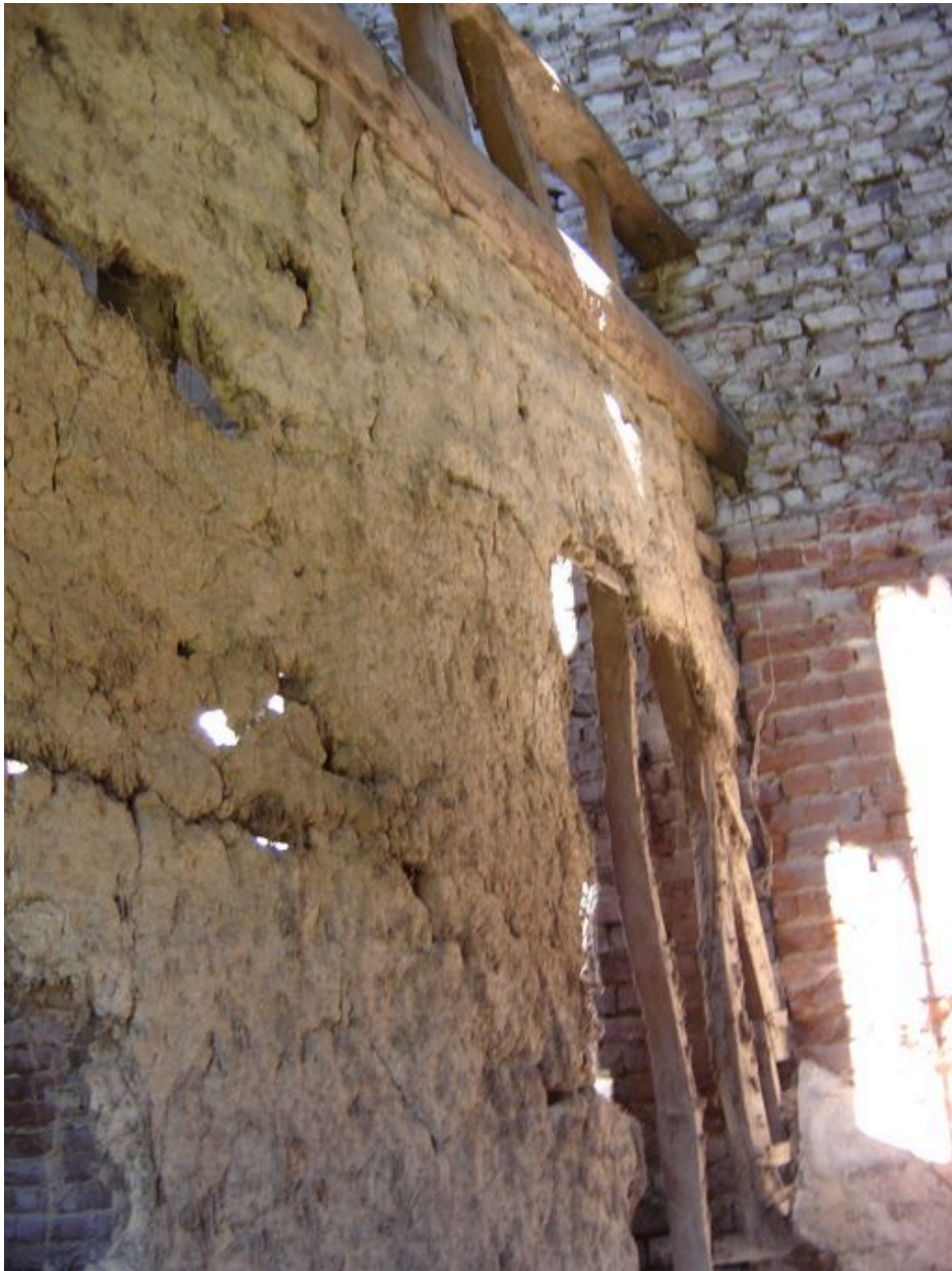
Vue de la cloison en torchis et pans de bois séparant les deux granges.
