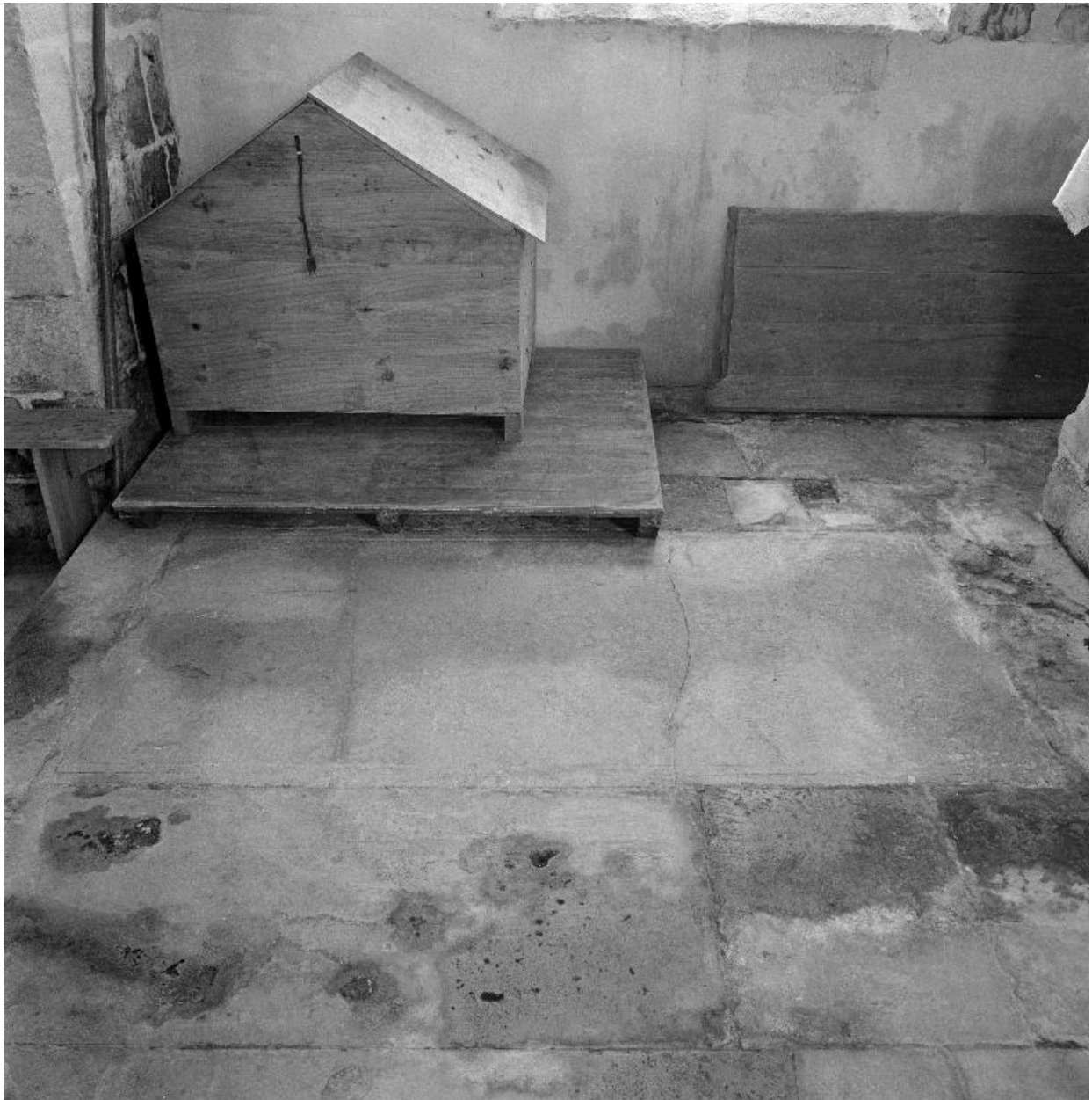
Vue générale de la dalle.
