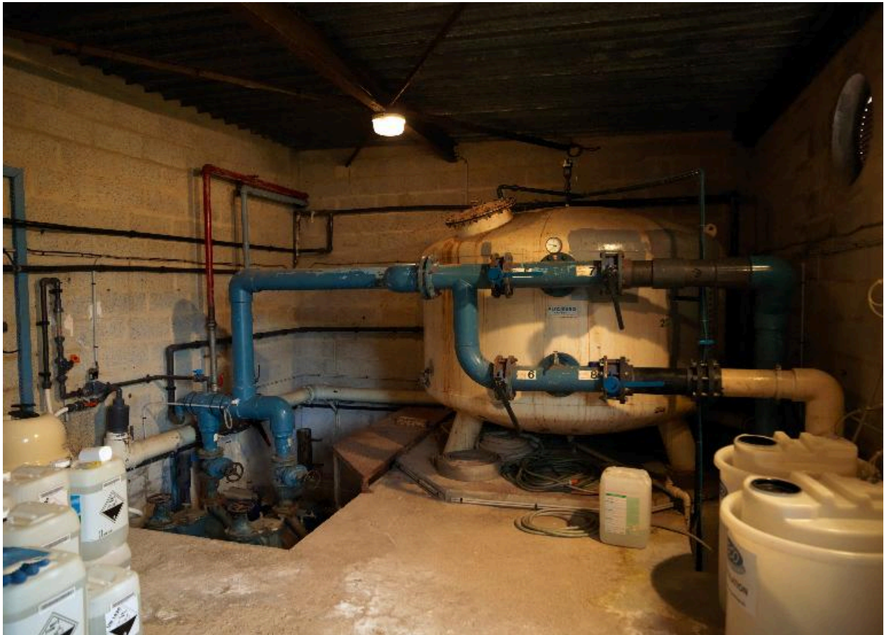
Local technique : filtre à sable "Piscinaro" (d'origine).
