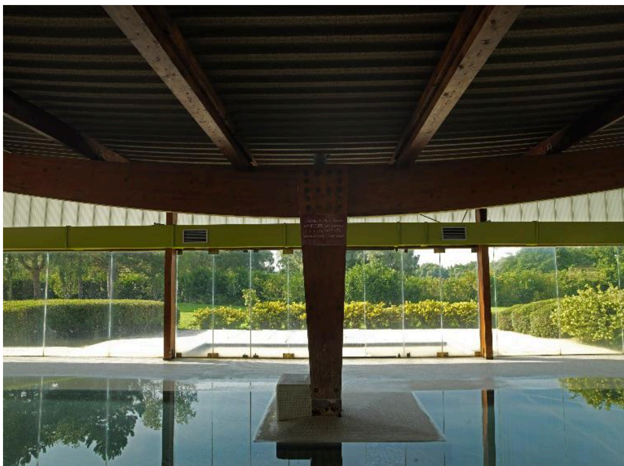
Détail de l'assemblage des poutres en bois lamellé-collé au niveau de la pataugeoire.
