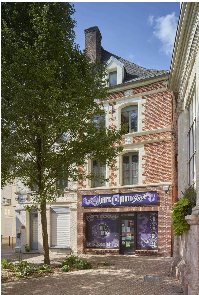
Détail de la façade du n°3, place Saint-Michel.
