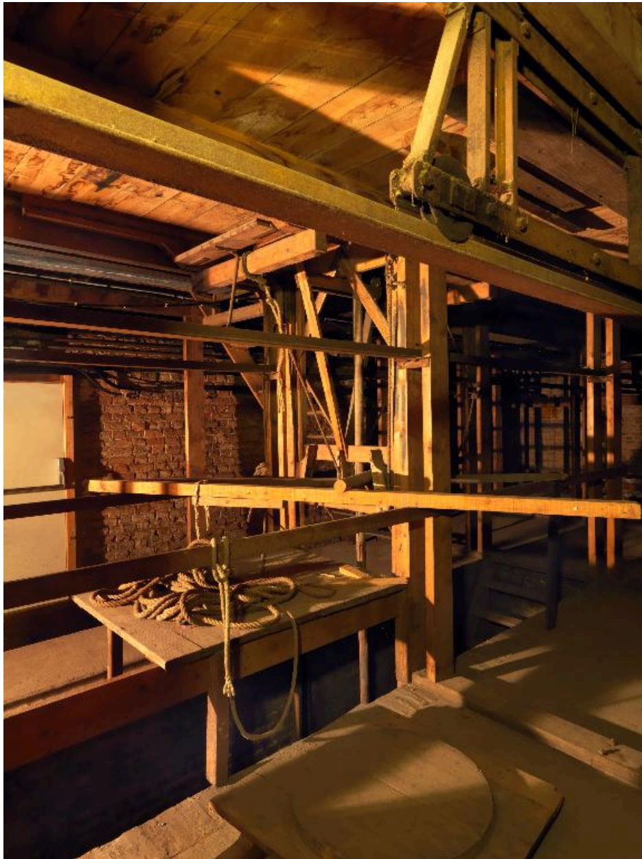
Dessous de scène, mécanisme de la trappe.
