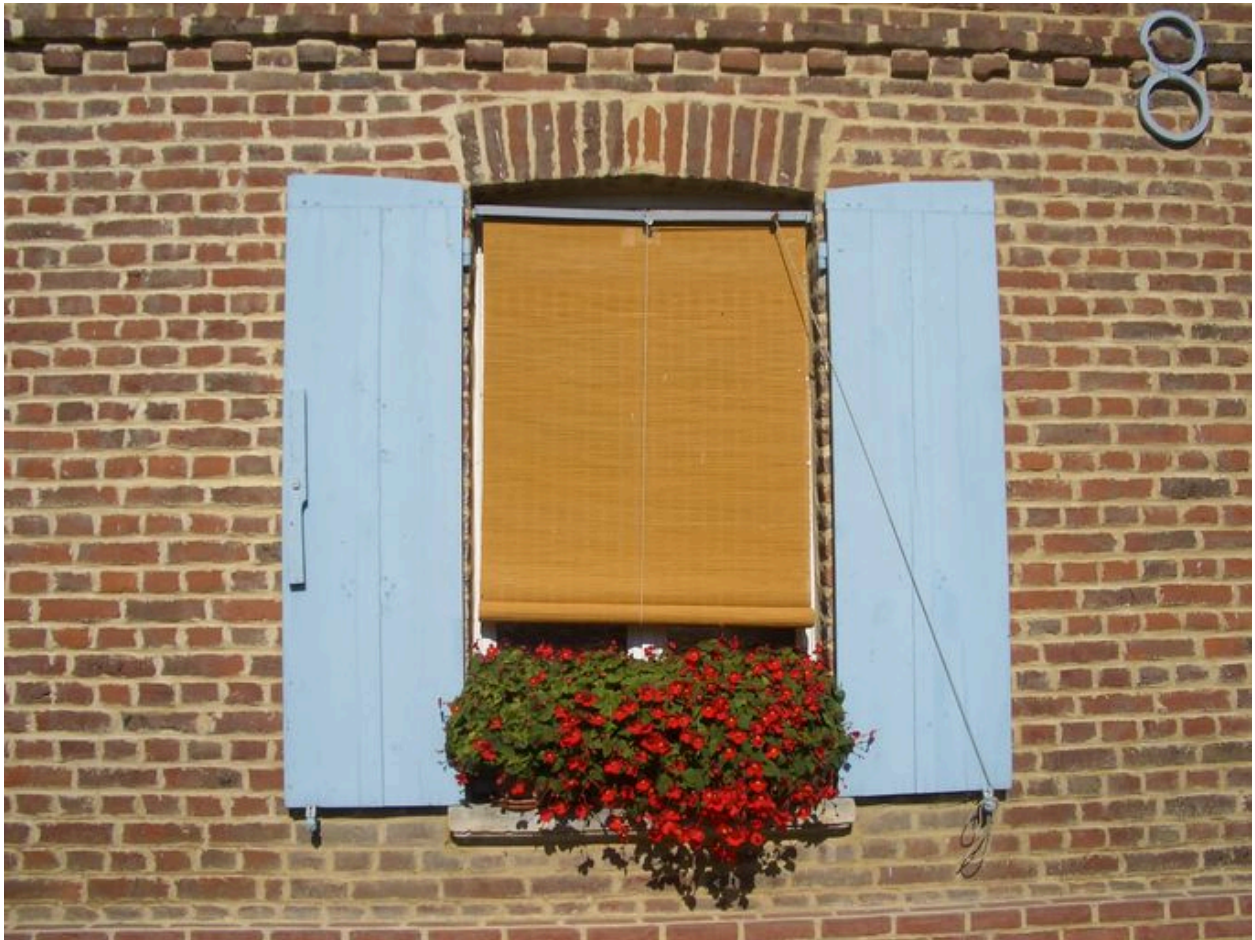
Vue détaillée d'une fenêtre et de son contrevent avec système de fermeture à tourniquet.
