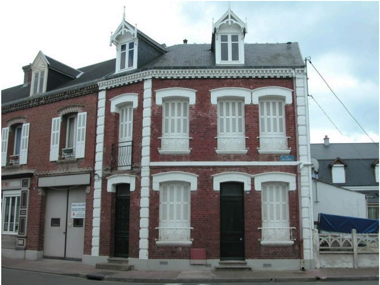
Vue d'ensemble du logement de droite.
