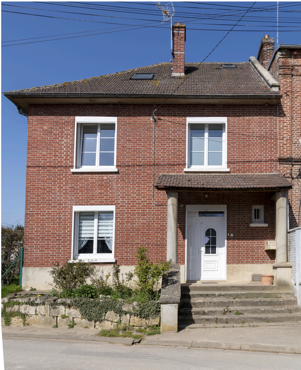
Logement reconstruit après les bombardements de 1940, n°1 rue de l'École. Vue prise depuis l'est.
