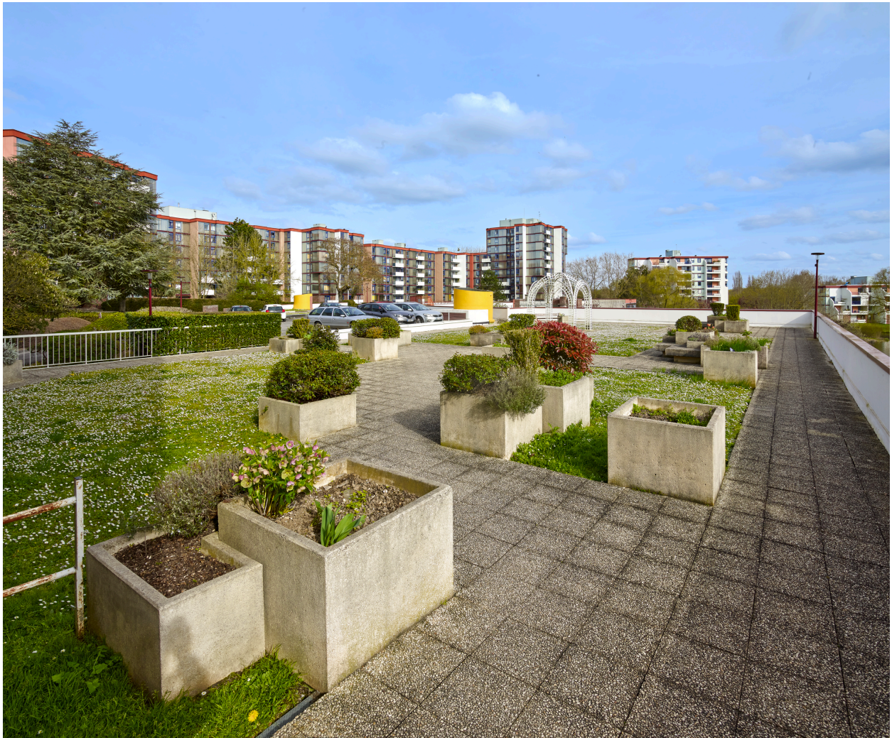
Jardinières-banc en béton sur le toit-terrasse du restaurant.
