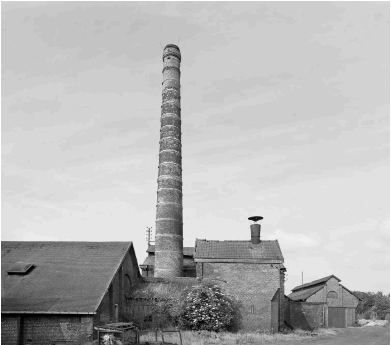
Vue extérieure des bâtiments industriels et de la cheminée d'usine.
