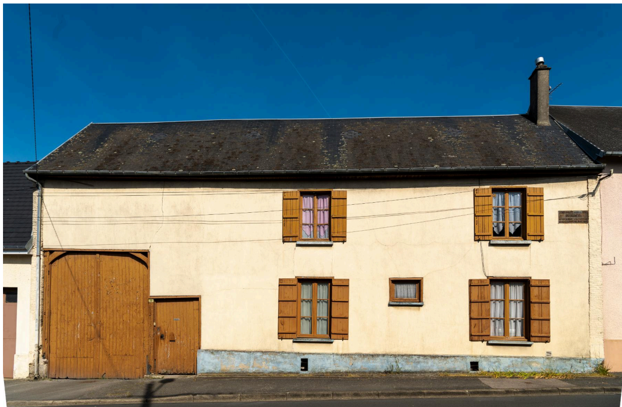
Logis sur rue, n°33 rue de Provinlieu, vue prise depuis l'est.
