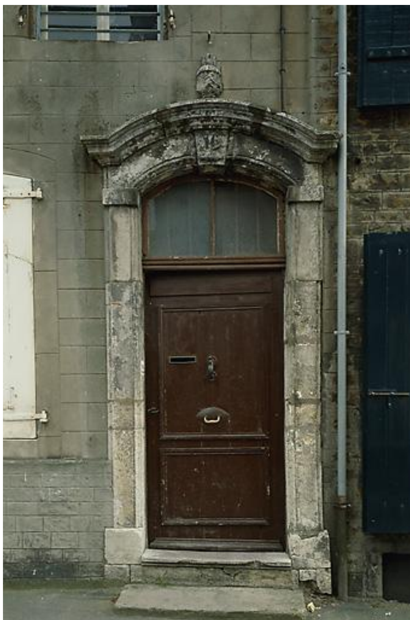
Façade sur voie, porte d'entrée : détail.
