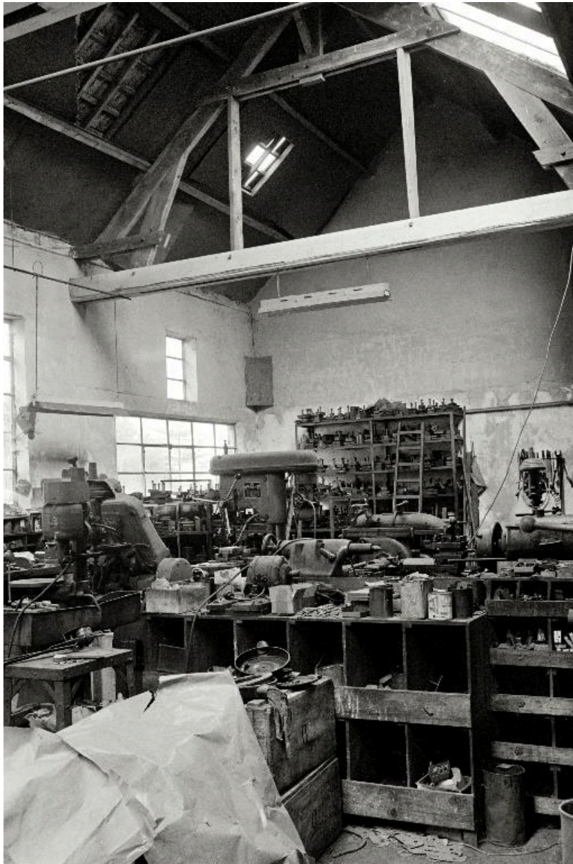
Atelier de fabrication, vue intérieure en 1990.
