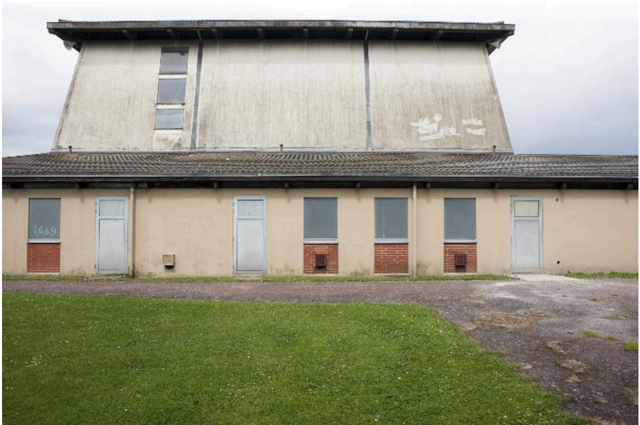
Élévation du flanc gauche de l'église.
