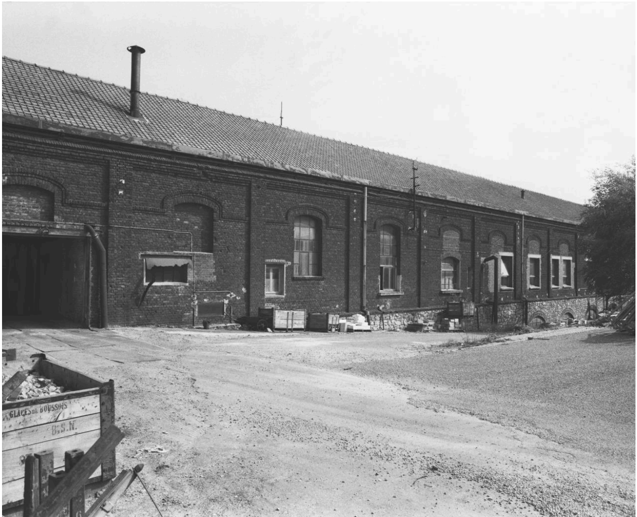
Vue générale de la halle à coulée.
