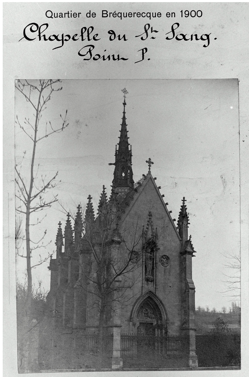
Vue d'angle nord-ouest, état en 1900. A.C. Boulogne-sur-Mer, clichés 1900.
