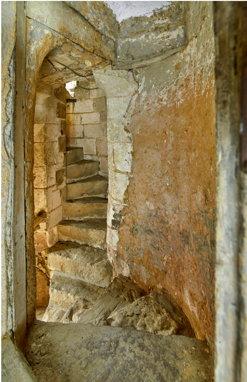
Escalier en vis logé dans une des tourelles et desservant les salles des étages supérieurs du beffroi.
