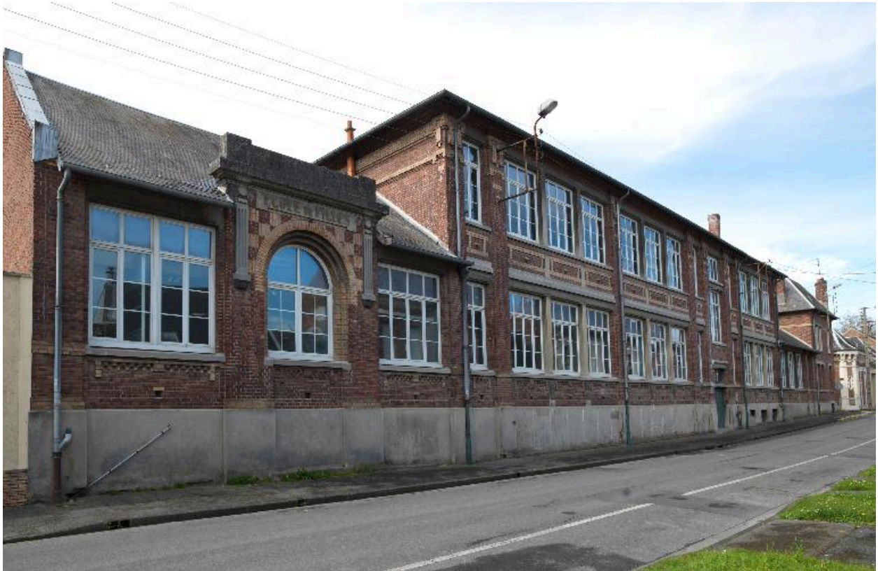
Vue de la nouvelle école de filles, rue du Théâtre.
